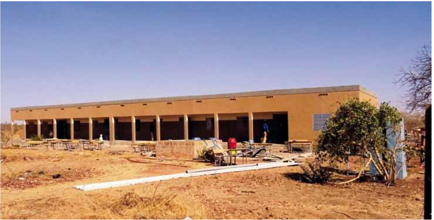
Das Collège in Sakoinsé ist teilweise noch im Bau
